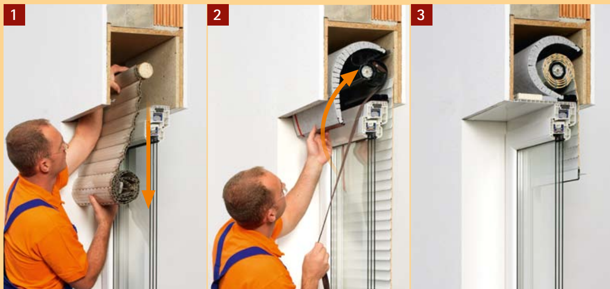
1 Alten Rollladen aus Kasten entfernen!
