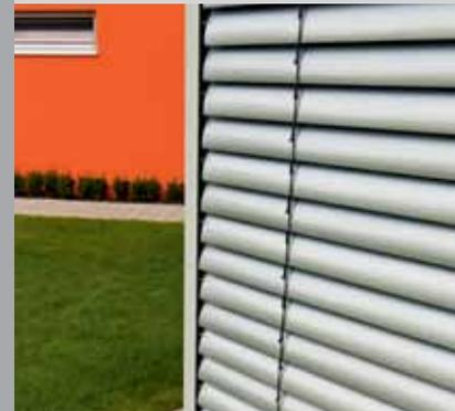
Beispiel mit geböckelter Raffstorelamelle und seitlichen Führungsschienen
