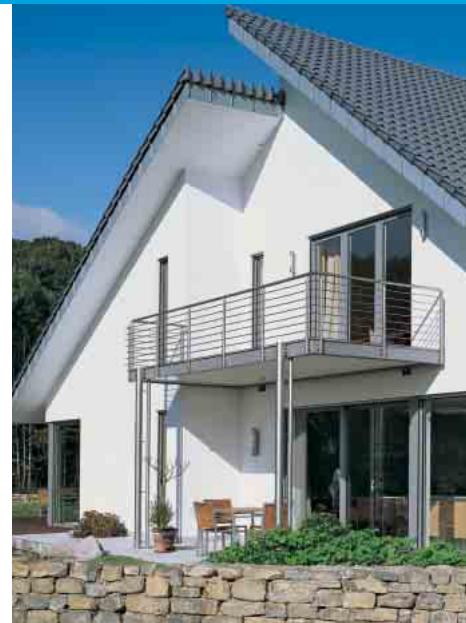
Design-Balkone – Blickfang einer jeden Fassade Feature balconies – the focal point of every façade
