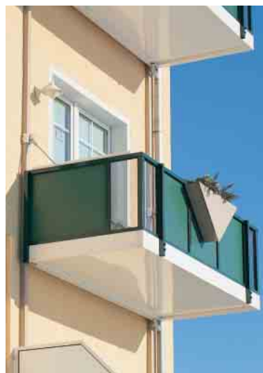
Freitragende Lösung, die kein Fundament und keine Stützen benötigt Cantilevered solution that does not require foundations and supports
