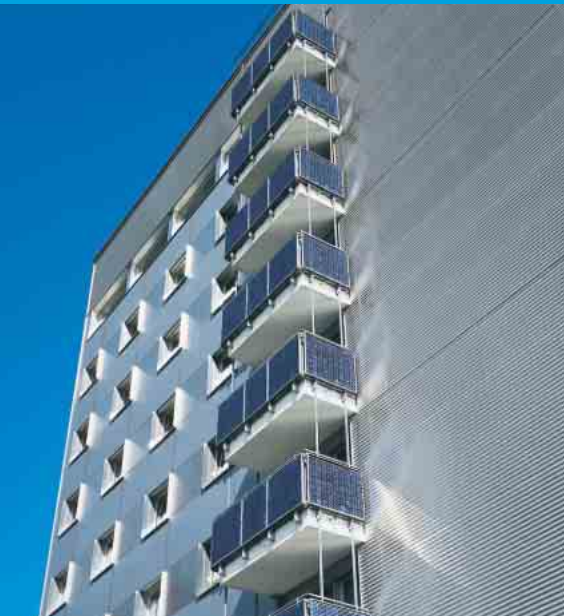
Aluminium Balkone mit ProSol Solarkollektoren Aluminium balconies with ProSol solar panels
